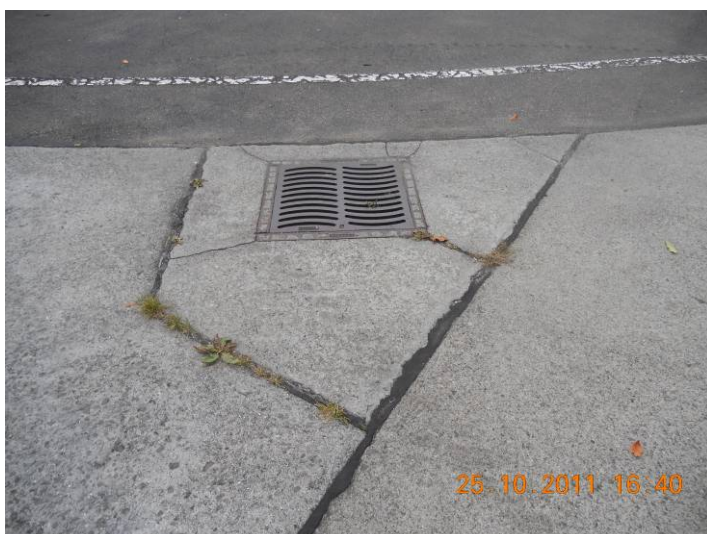
25.10.2011 Fugen mit Graswuchs, gebrochene Betonplatten
