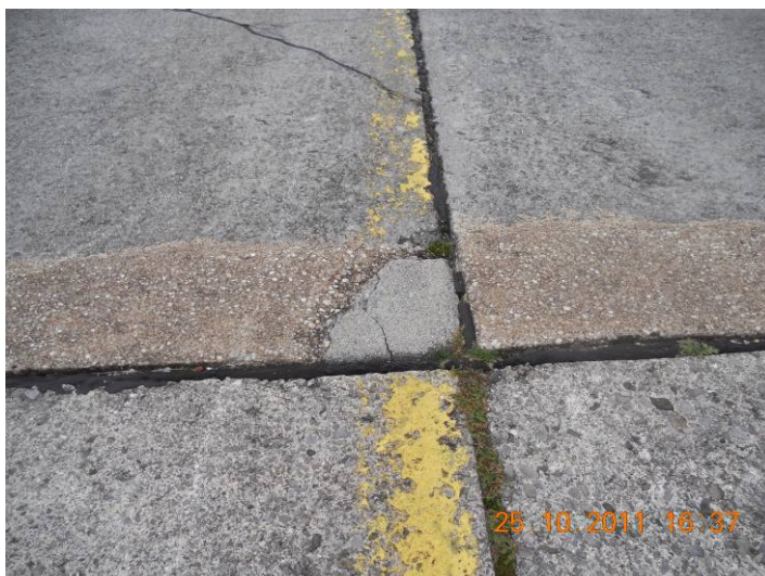
25.10.2011 Abgebrochene Betonkanten, Fugen mit Graswuchs
