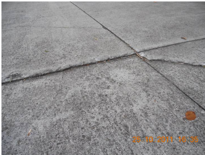
25.10.2011 Fugen mit Absätzen, gebrochene Betonplatten
