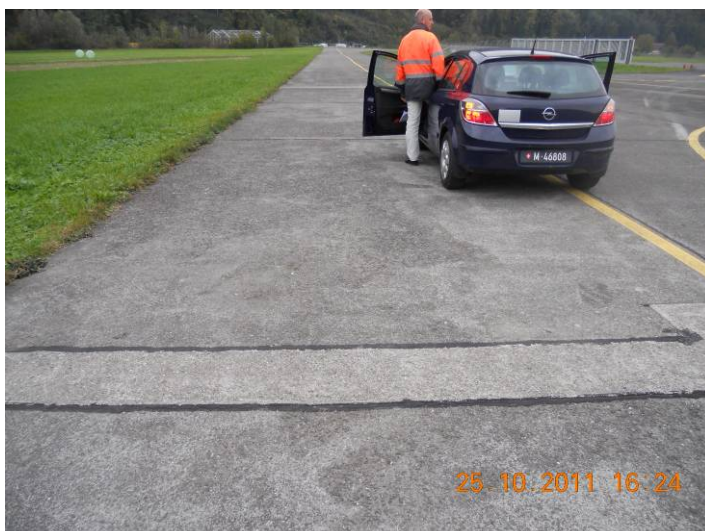
25.10.2011 Sicht Richtung Südosten Kornausbrüche in Betonplatten, Kantenabbrüche
