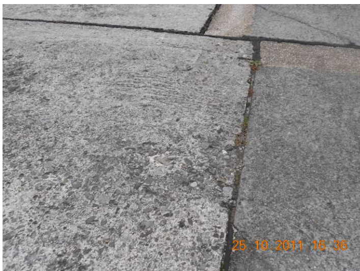
25.10.2011 Gebrochene Kanten, Graswuchs in Fugen
