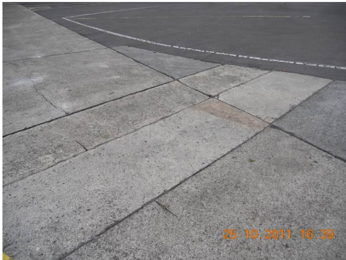
25.10.2011 Abgebrochene Betonkanten
