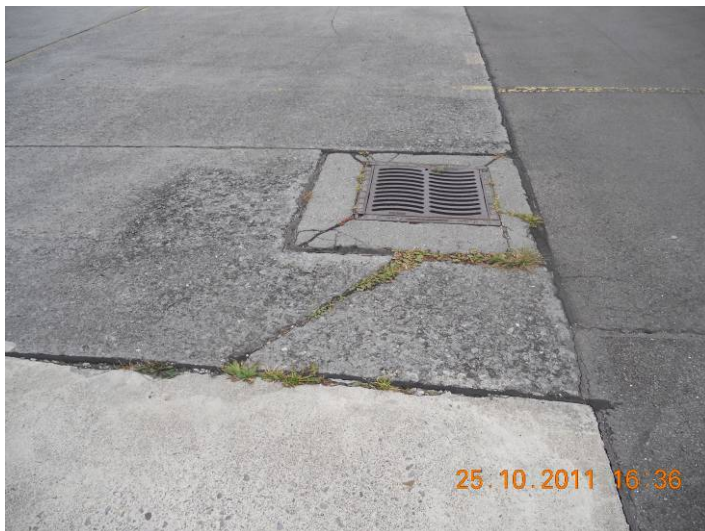
25.10.2011 Fugen mit Graswuchs, gebrochene Betonplatten
