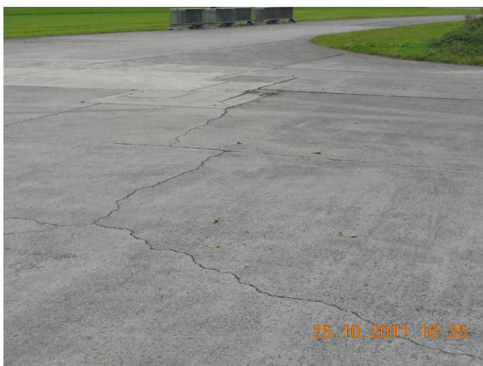
25.10.2011 Gebrochene Betonplatten
