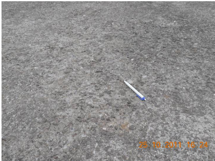
25.10.2011 Kornausbrüche in Betonplatten
